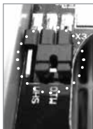
z linii napowietrznej
